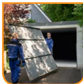
Ausbau und umwelt- gerechte Entsorgung
